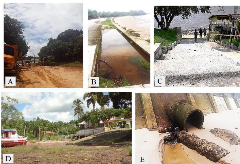
Figura 18 -Obras de infraestruturas presentes nas praias. (A) Marahú: rua de terra batida reparada por custeio dos moradores, (B) Bacuri: orla com acumulação de águas das chuvas, (C) Praia Grande: Plataforma de acesso, (D) Fazendinha: Plataforma de Embarque; (E) Bacuri: Dutos emissores.
