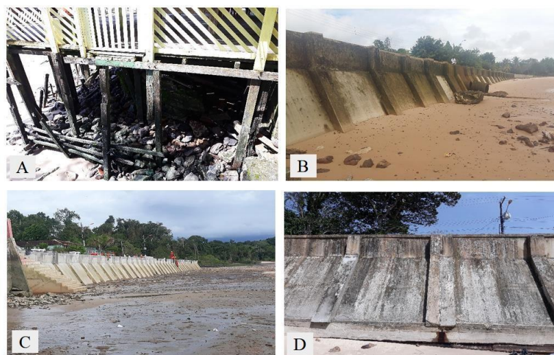
Figura 19 -Obras de proteção (Muros). (A) Praia Grande: Casa com barreiras de rochas, (B) Bacuri: presença de muros de arrimos, (C) Areião: construção do muro de arrimo, (D) Praia Grande: Muros de arrimos.
