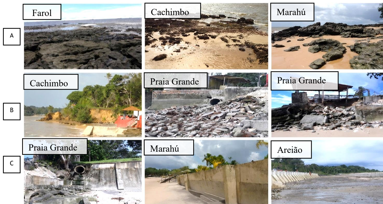
Figura 4- Indicadores de erosão evidentes na Ilha de Mosqueiro: (A) Afloramentos dos depósitos do Grupo Barreira e banco de cascalhos; (B) Desmoronamento de falésias e destruição de edificações; (C) Estruturas de contenção costeira (muros de arrimo)
