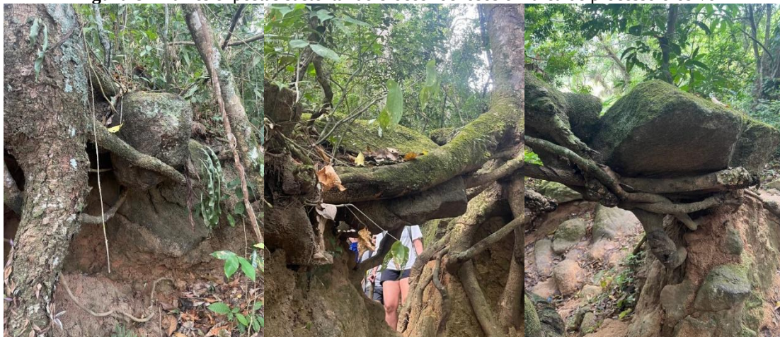
Figura 8 - Raízes expostas sustentando blocos rochosos em área de processo erosivo
