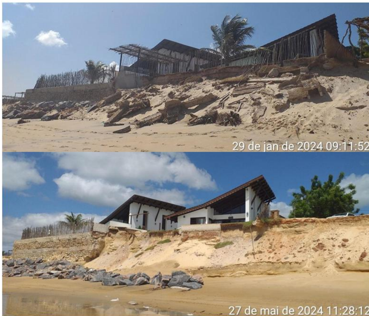
Figura 3 – Observação das alterações no perfil e condições da praia após a instalação de muro/aterro em um dos imóveis do Condomínio Monte Alegre, em um curto intervalo de tempo.
