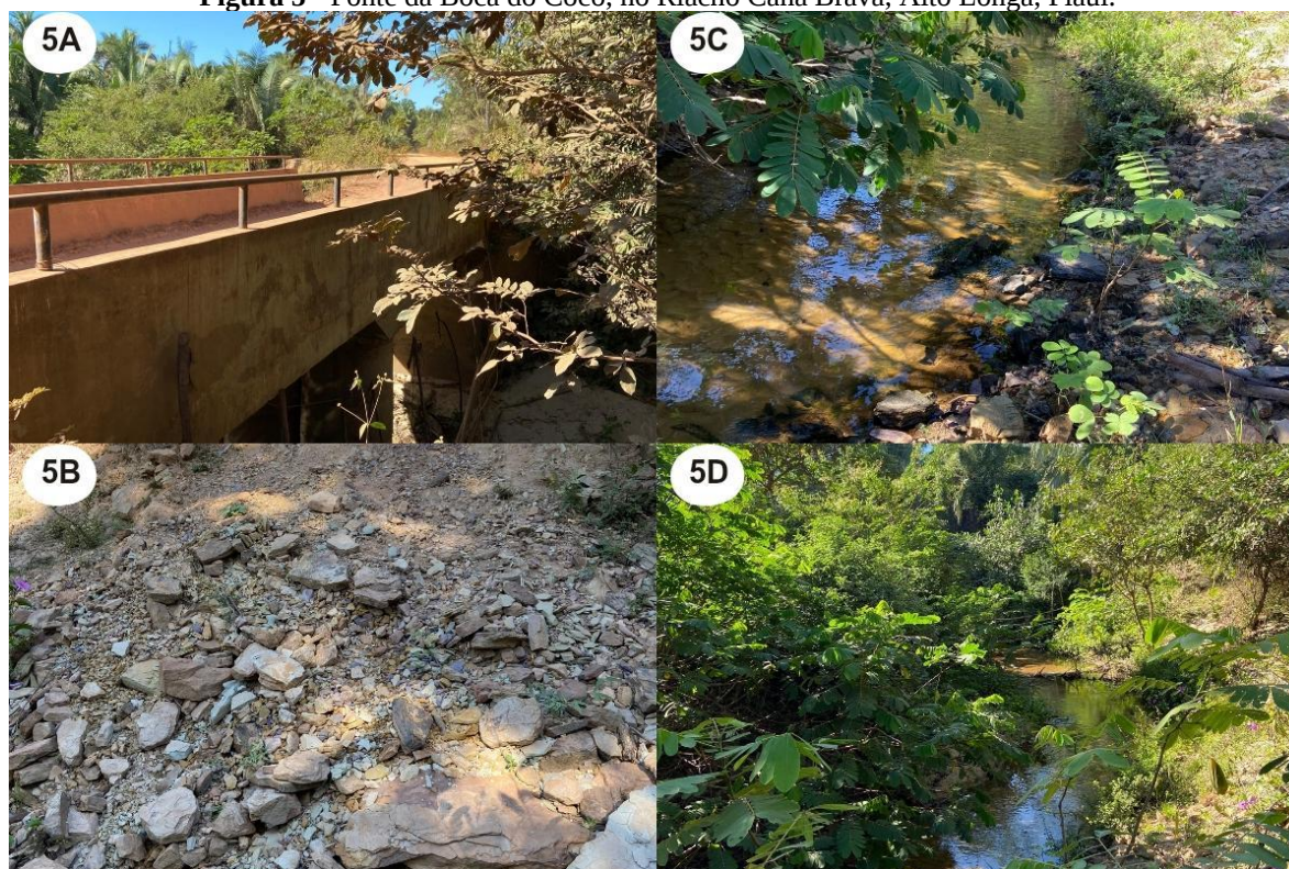
Figura 5 - Ponte da Boca do Coco, no Riacho Cana Brava, Alto Longá, Piauí.
