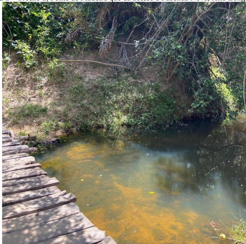
Figura 2 – Trecho 2, Ponte de Madeira que dá acesso à Fazenda Nova, Alto Longá, Piauí.
