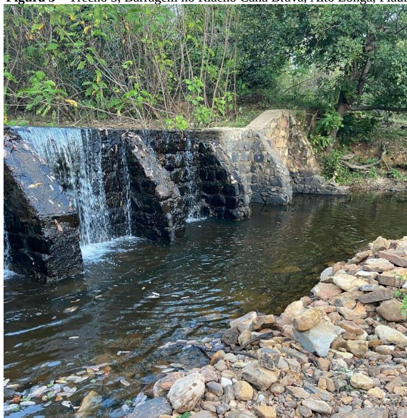
Figura 3 – Trecho 3, Barragem no Riacho Cana Brava, Alto Longá, Piauí.
