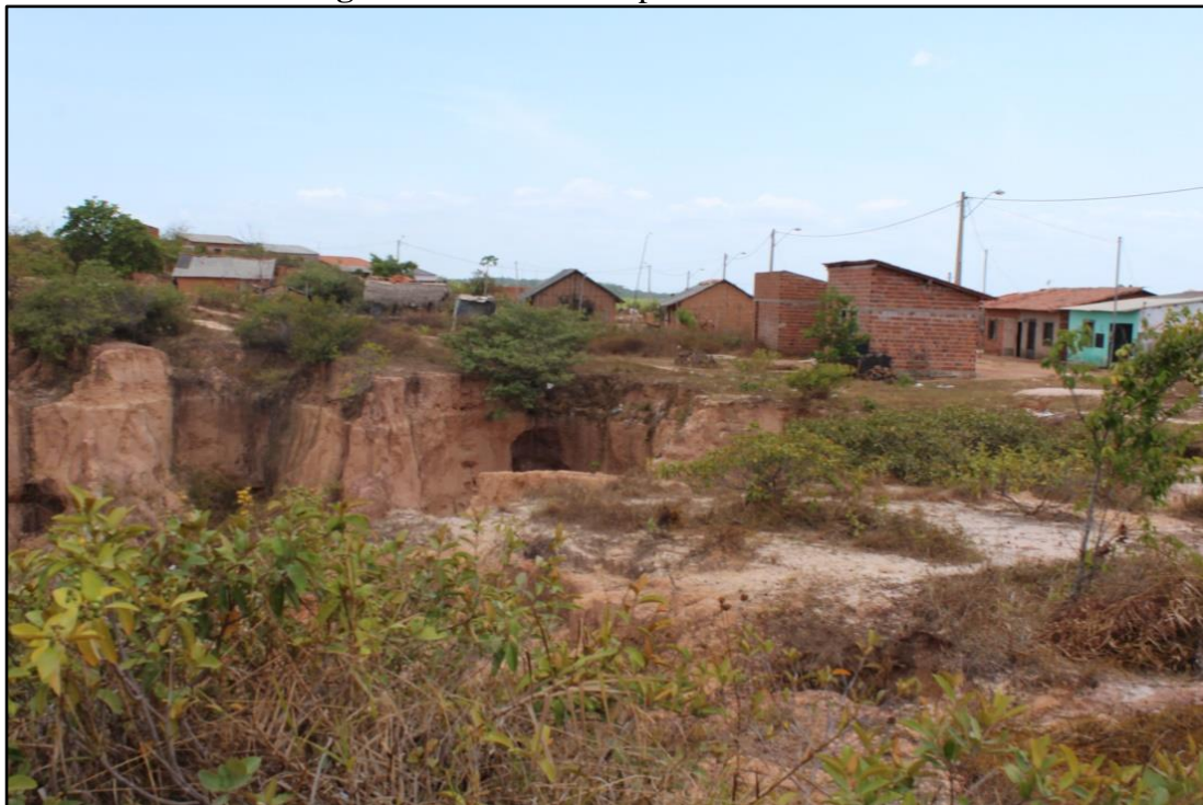
Figura 6 - Residências próximas a erosões
