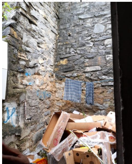
Figura 9 – Muro de contenção construído por um morador no bairro Alto São Simeão
