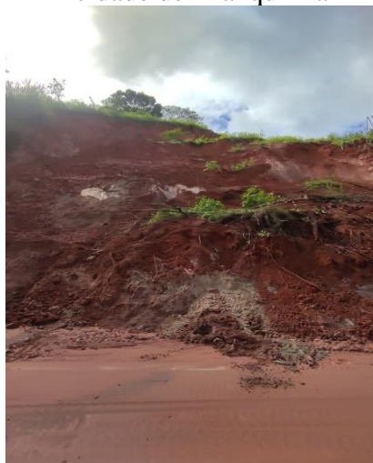
Figura 4 – Escorregamento de massa do tipo translacional na BR-104 às margens da cidade de Branquinha
