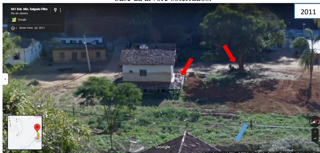
Figura 10. Planície do rio Cuiabá no Ponto 4, em 2011, com o primeiro pavimento da casa e base da árvore soterrados.
