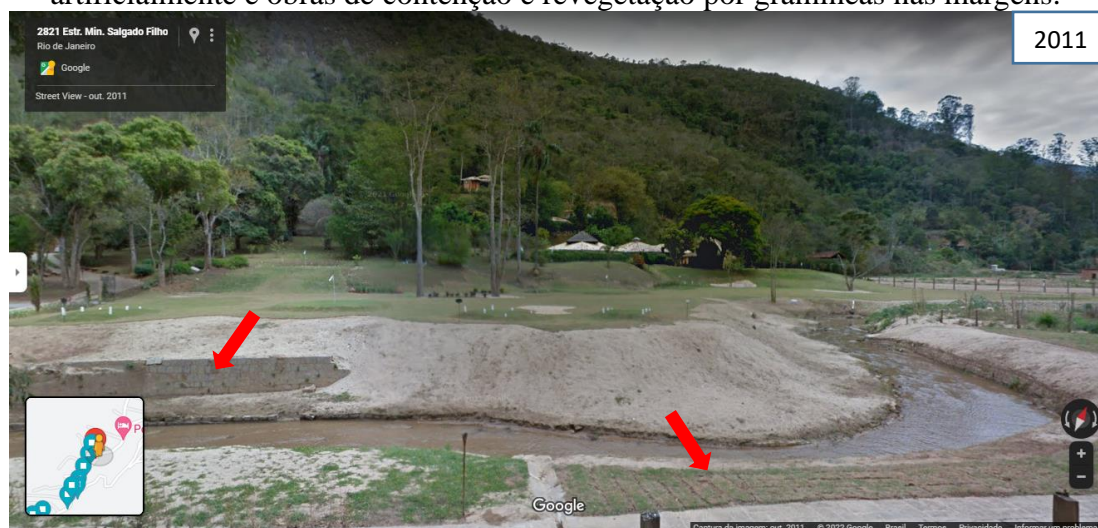
Fonte: Street View (2011). As setas vermelhas indicam a obra de contenção e revegetação.
