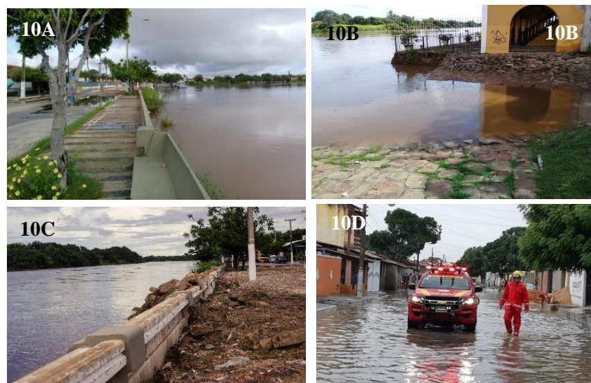
Figura 10. Cidade de Parnaíba (Piauí): aspectos do dique e da mureta sem manutenção e de ruas inundadas, em 2019
