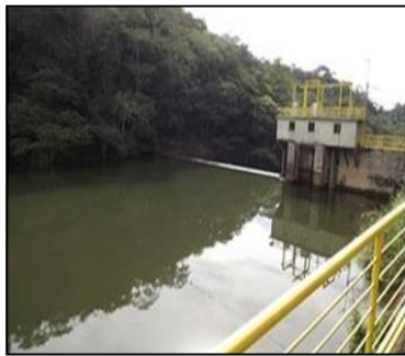
Reservatório de Tócos
