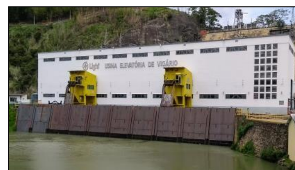
Usina elevatória de Vigário
