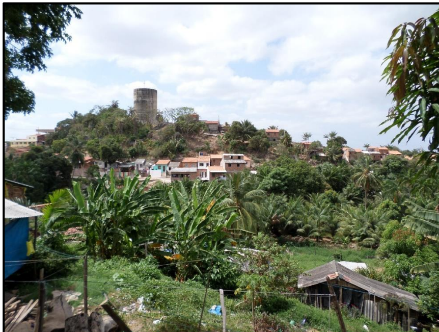
Figura 9 – Moradias fixadas na encosta com ocorrência de movimentos gravitacionais de massa.
