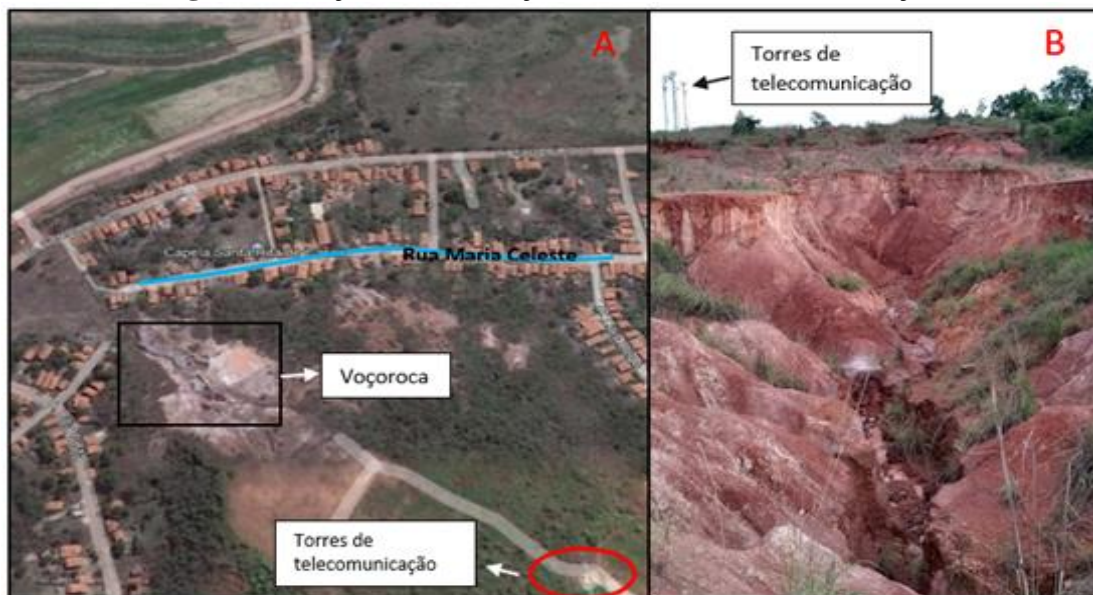
Figura 4 - Voçoroca em relação às torres de telecomunicação.
